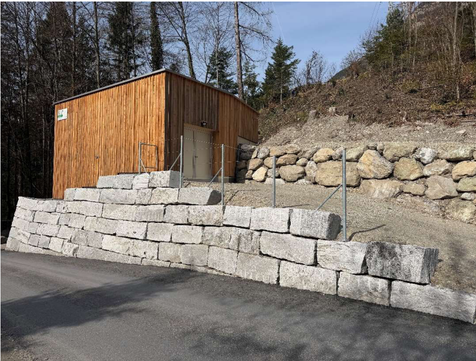
Neubau Trinkwasserkraftwerk Kohlplatz (Aussenansicht)
