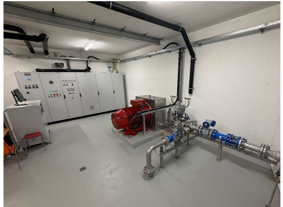
Neubau Trinkwasserkraftwerk Kohlplatz (Innenansicht)
